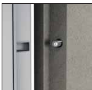
bezpečnostní trny proti vylomení – OPAL
